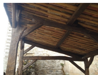
Fig. 3 : charpente en bois équarri @Photo P. Warengo
